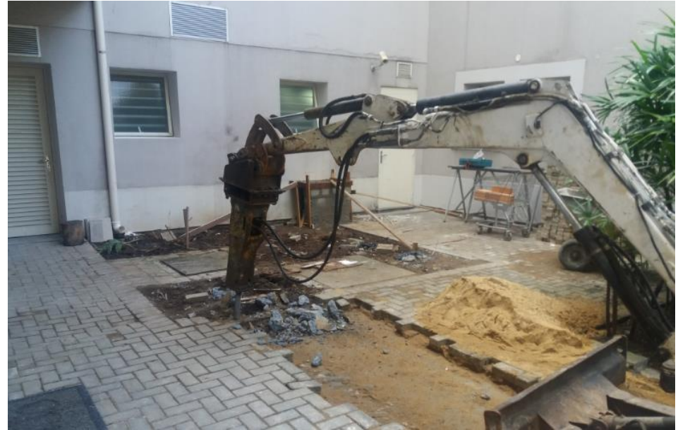
Diversas obras no RS
